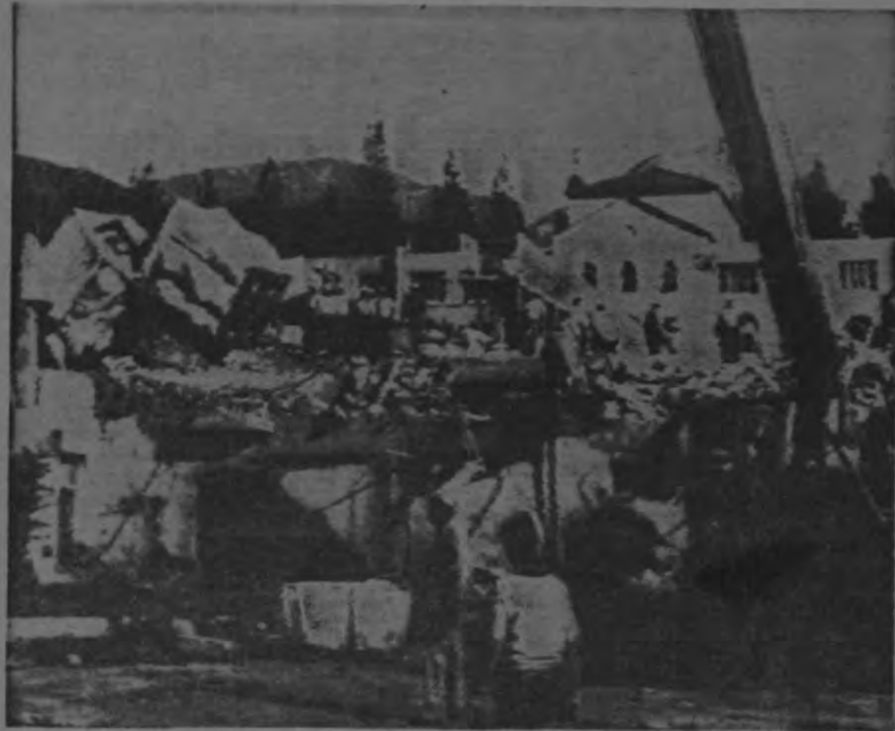
Cuadrillos de rescate usan grúas para remover los escombros del hospital de veteranos en Los Angeles en busca de víctimas por el sismo. La labor requerirá varios días para poder rescatar
